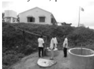
Implantation incohérente d'une pompe sous dimensionnée et inadéquate.
